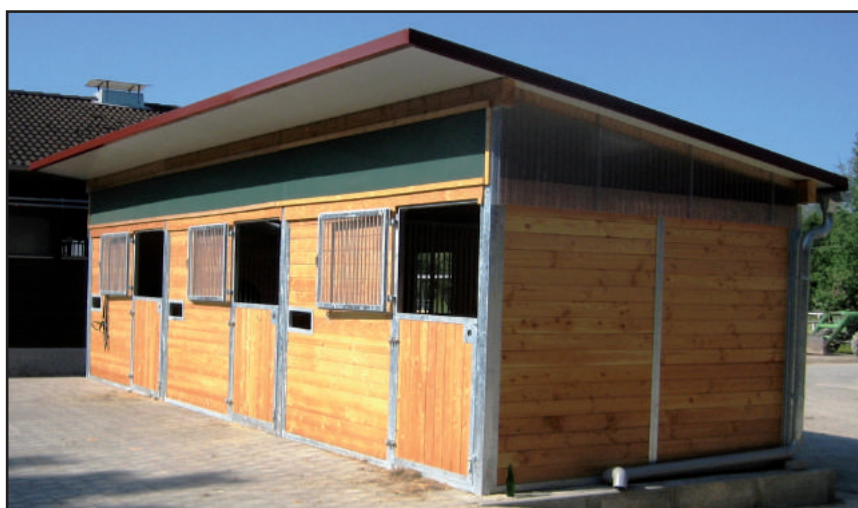
Ecurie de boxes extérieurs à une rangée en mesures standard. Face avant avec portes, face arrière avec fenêtres (supplément). Lumineuse à cause de translucides au pignon et filet brise-vent.
