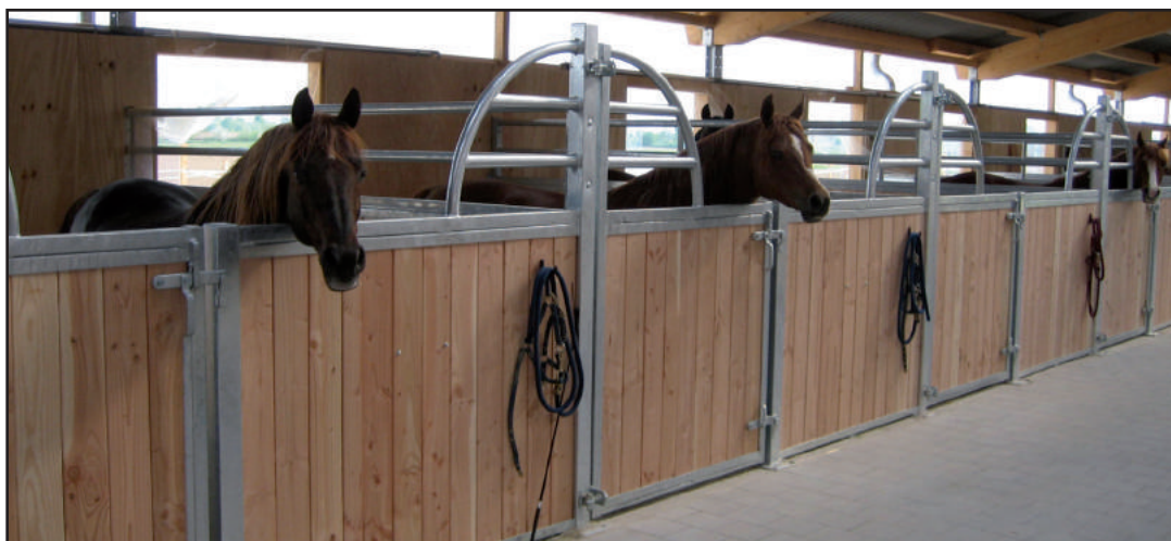
Boxes „Arizona“ sans tube vertical devant, séparations avec seulement 2 tubes verticaux
