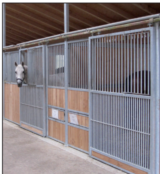
Portes coulissantes avec grille dans la partie basse pour une mieux aération
