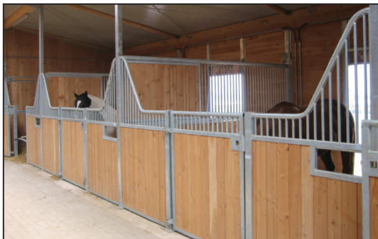
Boxes „Freiburg“ avec bois Douglas, portes pivotantes avec serrure à ressort
