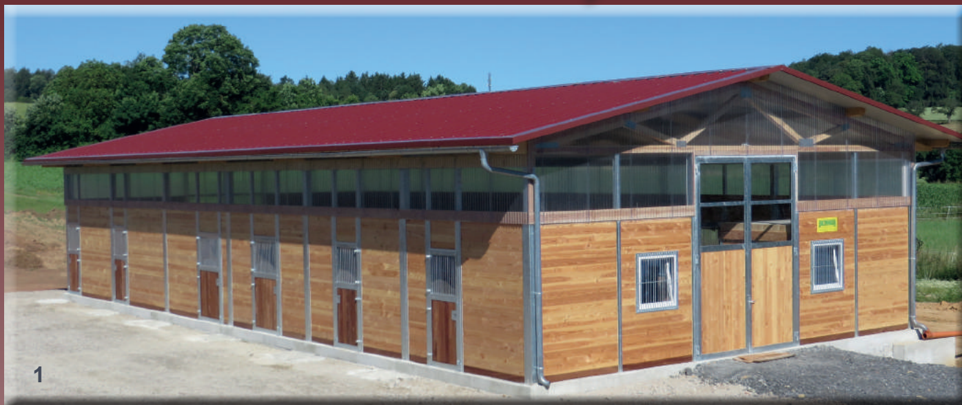
Ecurie à deux rangées avec bois Douglas et portes de boxes extérieurs
